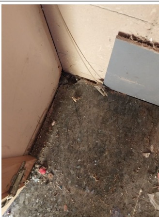
Prélèvement - P17 : BATIMENT 1 / RDC / SALLE DETENTE - Colle de carrelage- (Absence d'amiante)
