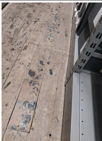
Prélèvement - P85 : BATIMENT 1 / R+2 / ARCHIVES 2 - Colle bitumineuse- (Absence d'amiante)
