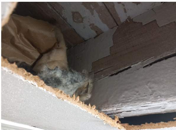
Prélèvement - P131 : BATIMENT 1 / R+2 / ARCHIVES 3 - Isolant- (Absence d'amiante)
