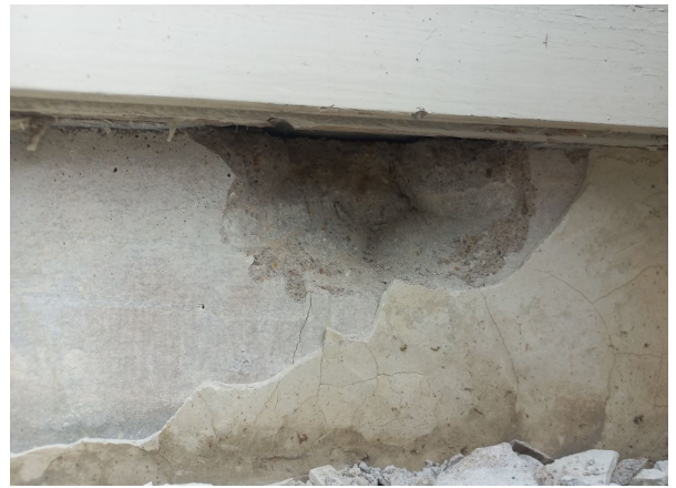
Prélèvement - P122 : BATIMENT 1 / EXTERIEUR / FACADES - Joint d'étanchéité entre menuiserie et structure- (Absence d'amiante)
