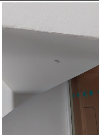
Prélèvement - P28 : BATIMENT 1 / RDC / ESC 01 - Enduit- (Absence d'amiante)
