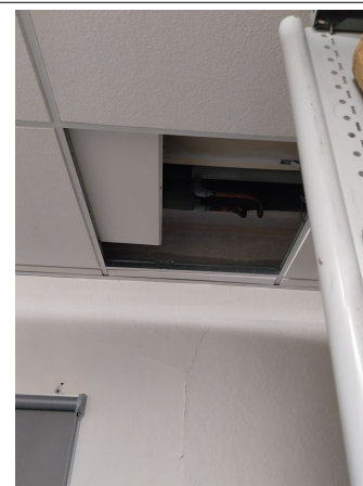
Prélèvement - P150 : BATIMENT 1 / R+1 / ARCHIVES 1 - Bande de plaque de plâtre- (Absence d'amiante)
