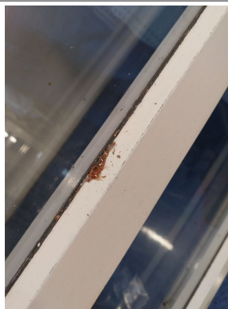
Prélèvement - P62 : BATIMENT 1 / R+1 / BUREAU 18 - Mastic- (Absence d'amiante)
