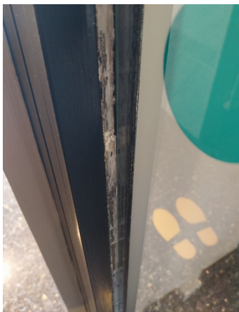
Prélèvement - P29 : BATIMENT 1 / RDC / DGT 01 - Mastic- (Absence d'amiante)
