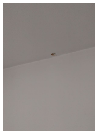
Prélèvement - P88 : BATIMENT 1 / R+3 / ARCHIVES 2 - Bande de plaque de plâtre- (Présence d'amiante)
