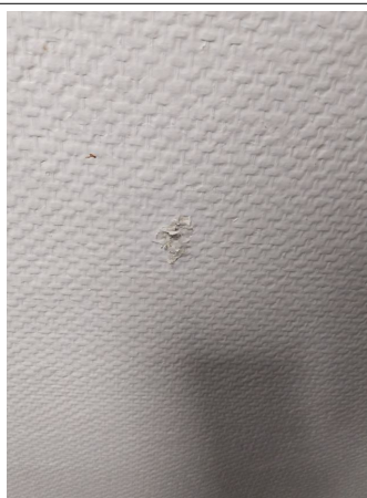
Prélèvement - P69 : BATIMENT 1 / R+1 / SALLE DETENTE - Bande de plaque de plâtre- (Absence d'amiante)
