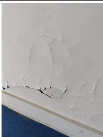
Prélèvement - P1 : BATIMENT 1 / RDC / SALLE LECTURE - Enduit- (Absence d'amiante)
