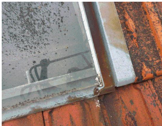
Prélèvement - P119 : BATIMENT 1 / EXTERIEUR / TOITURE - Mastic- (Absence d'amiante)
