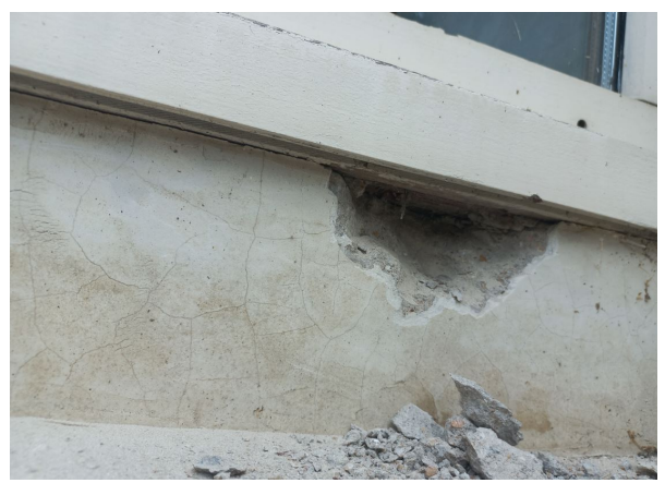
Prélèvement - P132 : BATIMENT 1 / EXTERIEUR / FACADES - Joint- (Absence d'amiante)
