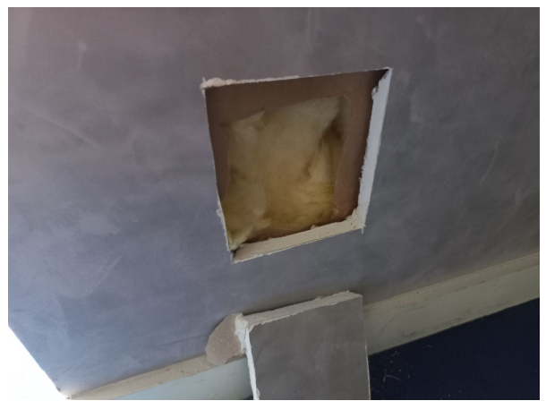
Prélèvement - P124 : BATIMENT 1 / RDC / SALLE MICRO FILMS - Isolant- (Absence d'amiante)
