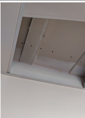
Prélèvement - P144 : BATIMENT 1 / R+1 / BUREAU 14A - Bande de plaque de plâtre- (Absence d'amiante)
