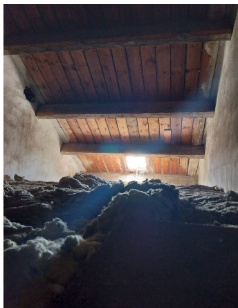
Prélèvement - P107 : BATIMENT 1 / COMBLES / 1 - Isolant- (Absence d'amiante)
