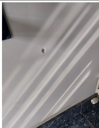
Prélèvement - P32 : BATIMENT 1 / RDC / DGT 02 - Enduit- (Absence d'amiante)
