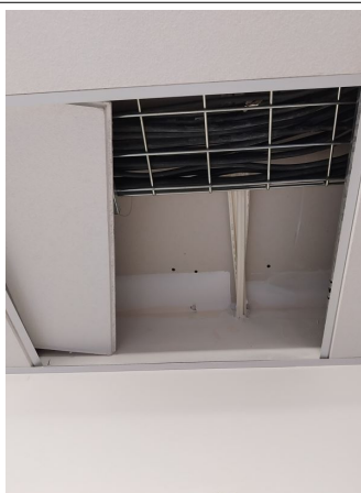
Prélèvement - P149 : BATIMENT 1 / R+1 / ARCHIVES 2 - Bande de plaque de plâtre- (Absence d'amiante)
