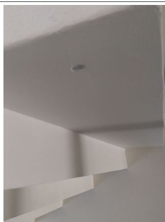
Prélèvement - P33 : BATIMENT 1 / RDC / ESC 02 - Enduit- (Absence d'amiante)
