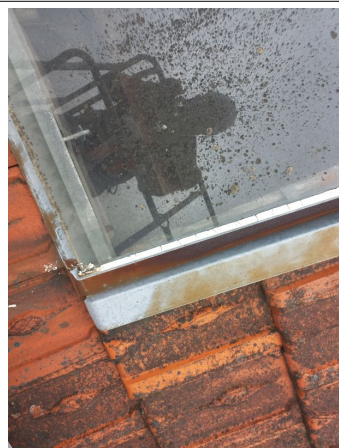
Prélèvement - P118 : BATIMENT 1 / EXTERIEUR / TOITURE - Mastic- (Absence d'amiante)
