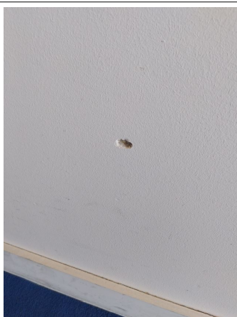
Prélèvement - P3 : BATIMENT 1 / RDC / SALLE LECTURE - Enduit- (Absence d'amiante)
