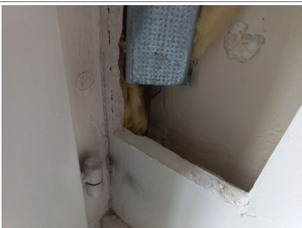
Prélèvement - P135 : BATIMENT 1 / R+1 / SALLE REUNION - Isolant- (Absence d'amiante)
