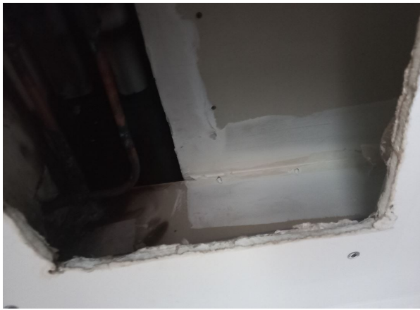
Prélèvement - P127 : BATIMENT 1 / R+1 / SALLE REUNION - Bande de plaque de plâtre- (Absence d'amiante)
