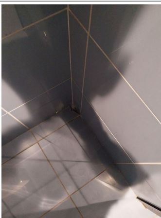
Prélèvement - P23 : BATIMENT 1 / RDC / WC F - Colle de carrelage- (Absence d'amiante)
