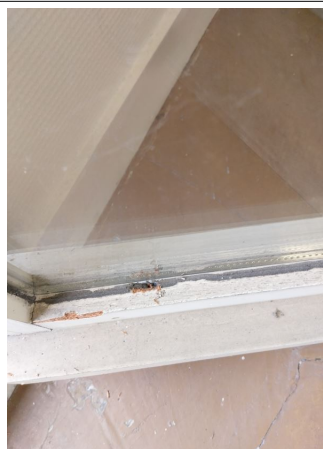
Prélèvement - P50 : BATIMENT 1 / RDC / ARCHIVES - Mastic- (Absence d'amiante)
