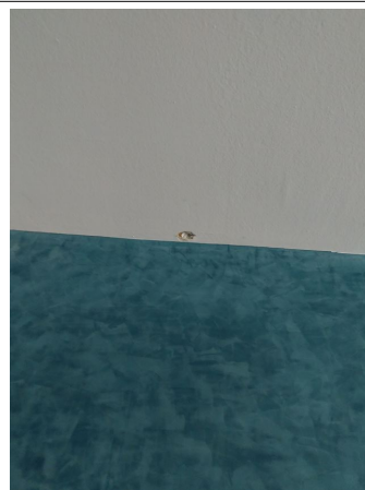
Prélèvement - P92 : BATIMENT 1 / R+3 / ESC 2 - Bande de plaque de plâtre- (Présence d'amiante)
