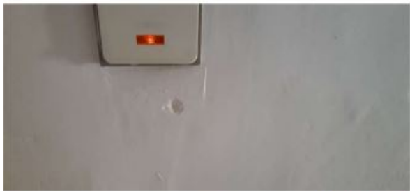
Prélèvement - P01 : R+3 / Dégagement 31 - Enduit- (Présence d'amiante)
