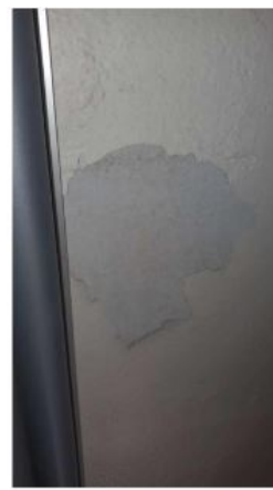
Déclaré - : BATIMENT 1 / R+1 / ARCHIVES 1 - Enduit- (Présence d'amiante)
