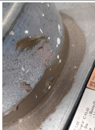
Prélèvement - P76 : BATIMENT 1 / R+3 / LOCAL VMC - Mastic - (Absence d'amiante)
