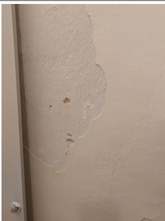
Prélèvement - P141 : BATIMENT 1 / R+1 / LOCAL TECHNIQUE - Enduit- (Absence d'amiante)
