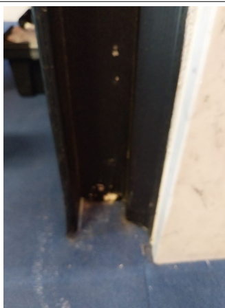
Prélèvement - P47 : BATIMENT 1 / RDC / STOCKAGE ARCHIVES - Joint coupe-feu- (Absence d'amiante)
