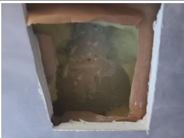
Prélèvement - P125 : BATIMENT 1 / RDC / SALLE MICRO FILMS - Enduit- (Absence d'amiante)
