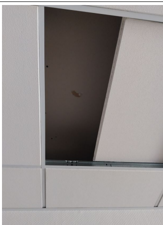
Prélèvement - P87 : BATIMENT 1 / R+3 / ARCHIVES 1 - Bande de plaque de plâtre- (Absence d'amiante)
