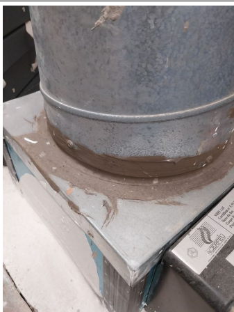
Prélèvement - P75 : BATIMENT 1 / R+2 / ARCHIVES 1 - Mastic - (Absence d'amiante)
