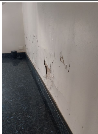
Prélèvement - P26 : BATIMENT 1 / RDC / ESC 01 - Enduit- (Absence d'amiante)
