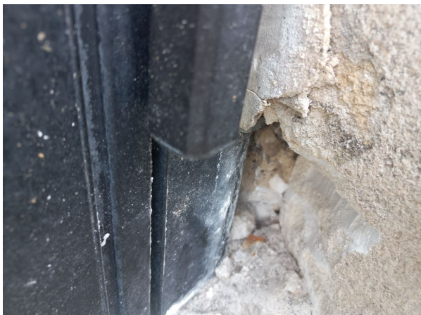
Prélèvement - P123 : BATIMENT 1 / EXTERIEUR / FACADES - Joint d'étanchéité entre menuiserie et structure- (Absence d'amiante)
