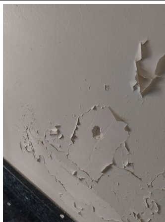
Prélèvement - P27 : BATIMENT 1 / RDC / ESC 01 - Enduit- (Absence d'amiante)
