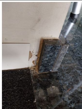
Prélèvement - P20 : BATIMENT 1 / RDC / DGT 02 - Colle de plinthe- (Absence d'amiante)
