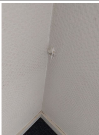
Prélèvement - P90 : BATIMENT 1 / R+3 / BUREAU 39 - Enduit- (Absence d'amiante)
