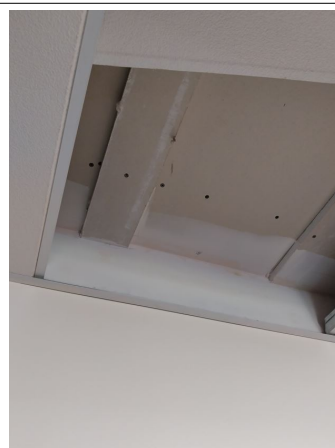
Prélèvement - P148 : BATIMENT 1 / R+1 / BUREAU PREPA ARCHIVES - Bande de plaque de plâtre- (Absence d'amiante)
