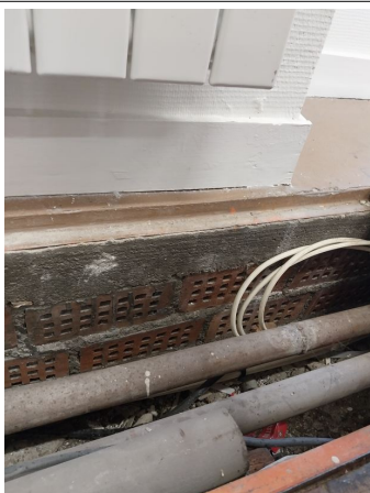
Prélèvement - P45 : BATIMENT 1 / RDC / ARCHIVES - Enduit- (Absence d'amiante)
