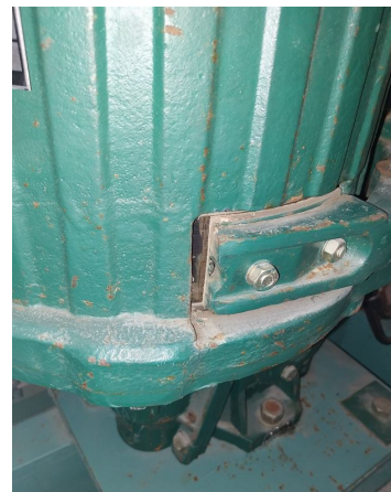
Prélèvement - P154 : BATIMENT 1 / COMBLES / MACHINERIE ACSEUSEUR - Frein- (Présence d'amiante)
