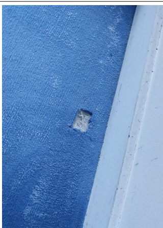
Prélèvement - P6 : BATIMENT 1 / RDC / SALLE REUNION - Colle- (Absence d'amiante)
