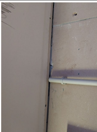
Prélèvement - P15 : BATIMENT 1 / RDC / SALLE DETENTE - Colle de faïence- (Absence d'amiante)
