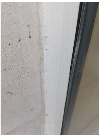
Prélèvement - P111 : BATIMENT 1 / EXTERIEUR / FACADES - Joint d'étanchéité entre menuiserie et structure- (Absence d'amiante)
