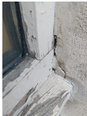
Prélèvement - P110 : BATIMENT 1 / EXTERIEUR / FACADES - Joint d'étanchéité entre menuiserie et structure- (Absence d'amiante)
