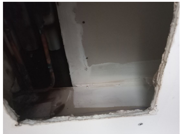
Prélèvement - P128 : BATIMENT 1 / R+1 / SALLE REUNION - Bande de plaque de plâtre- (Absence d'amiante)
