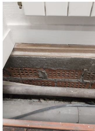
Prélèvement - P44 : BATIMENT 1 / RDC / ARCHIVES - Enduit- (Absence d'amiante)
